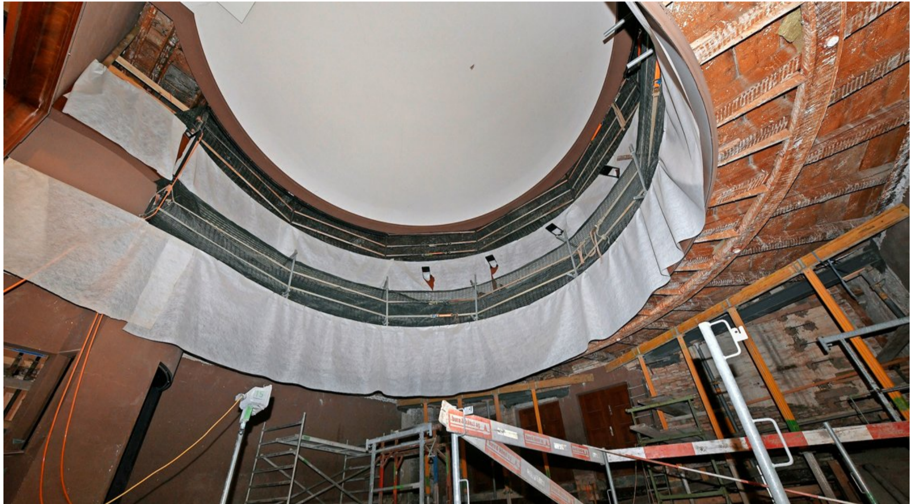
Die Holzverkleidung der Balkonetagen ist zum Schutz abgedeckt, alles andere im Theatersaal des Casinos wird erneuert und den Anforderungen der Zeit angepasst.
