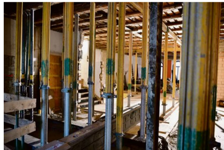
Deckenstützen dominieren das Bild: Im Foyer des Kulturhauses werden in zehn Monaten wieder Besucherinnen und Besucher empfangen.
