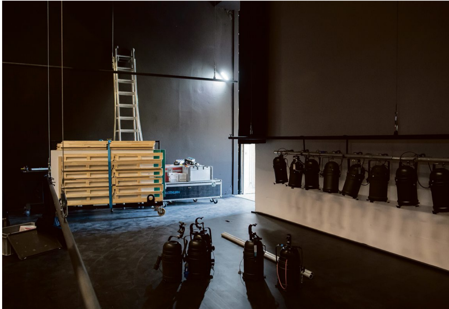
Die Scheinwerfer werden mit den neuen Kulissenzügen zur Decke befördert. Fotos: Franziska Rothenbühler
