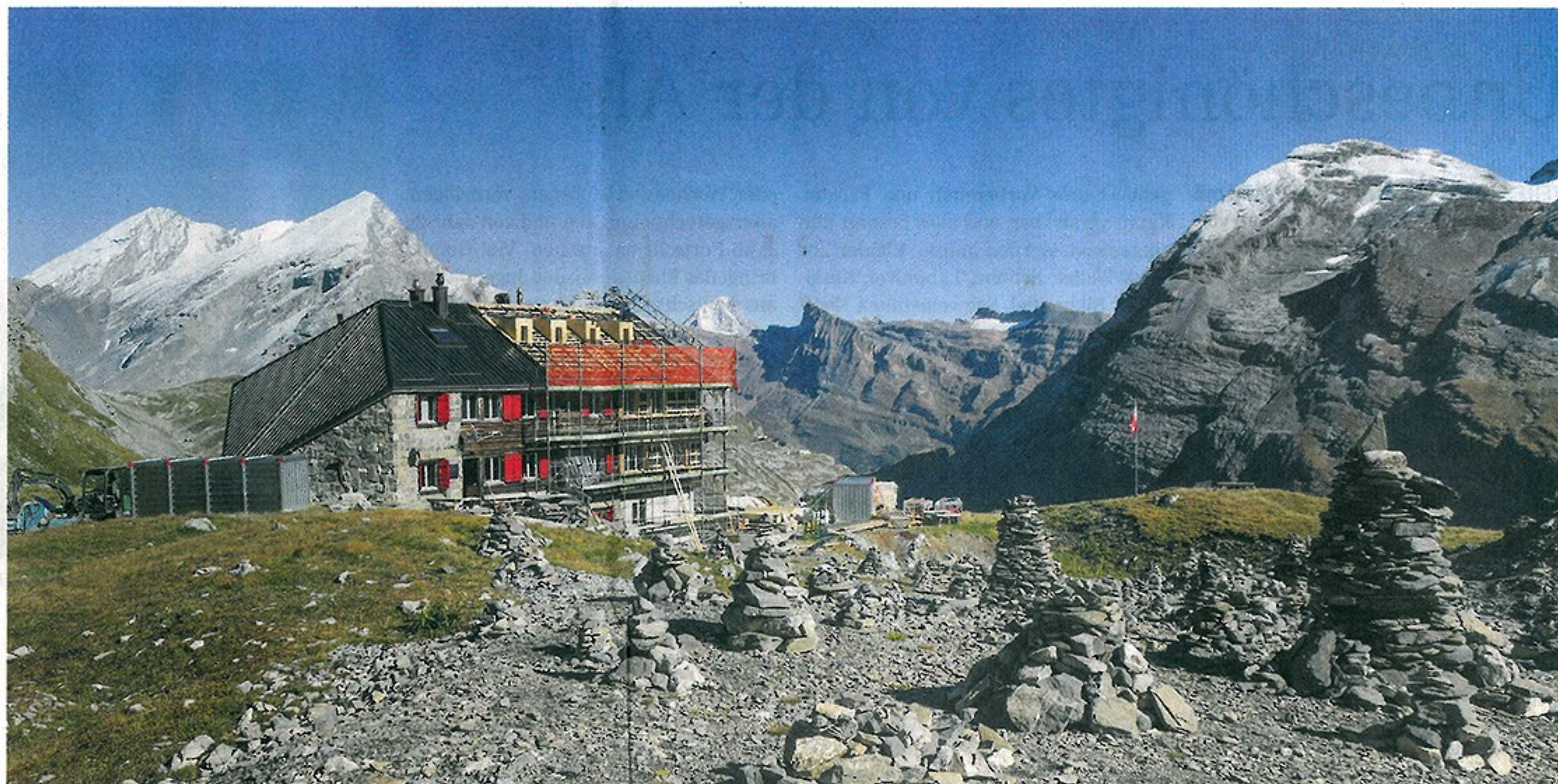
Die Lämmerenhütte erhält sich auch mit ihrem Anbau das Aussehen einer wohlproportionierten, traditionellen SAC Hütte.
